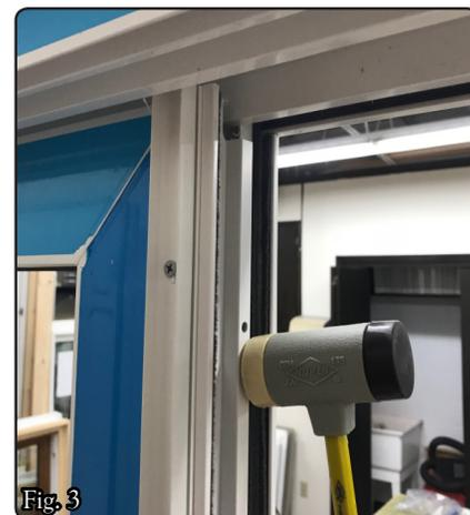
Consulte las Fig. 2 y 3. Asegúrese de que el parteluz en H esté nivelado con la parte inferior del panel del paño fijo. Usando un mazo de goma, golpee suavemente el parteluz en H sobre el panel fijo como se muestra. Tendrá que golpear este parteluz en H con cierta fuerza para que las patas se enganchen en el compartimento del paño fijo.
